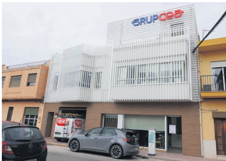
Imatge de la nova façana
